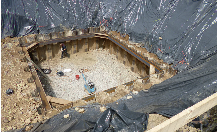
Neubau Vorklärbecken | Winterbach
